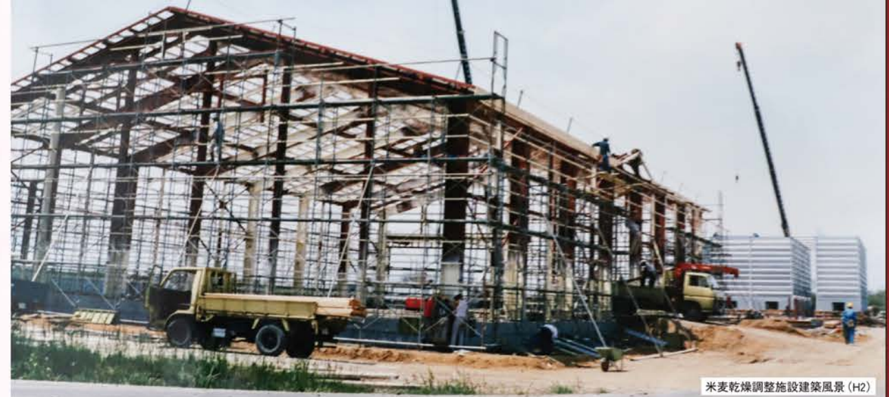
米麦乾燥調整施設建築風景 (H2)
